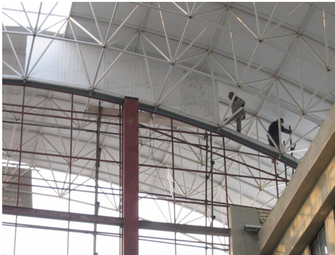
نصب ساندویچ پانل‌های حاشیه وید داخلی پروژه، ۱۳۹۱/۴/۲۳
